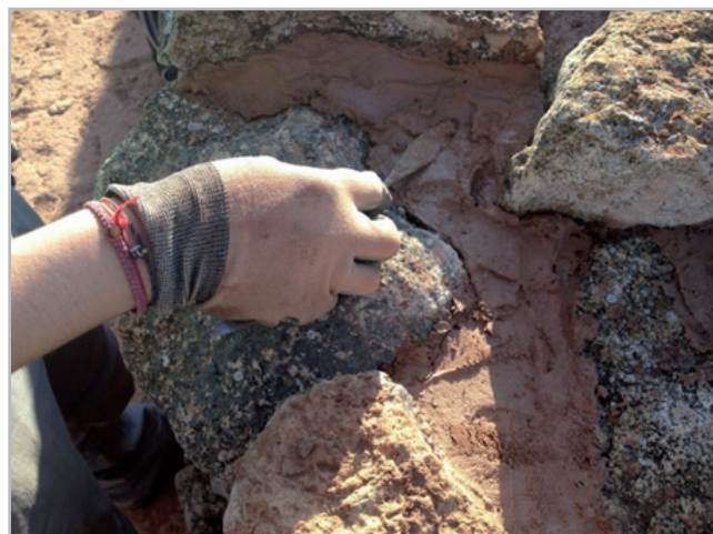
Figura 3.- Trabajos de espatulado.
