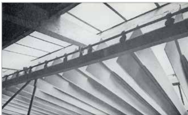
Figura 11.- Sistema de regulação da luz zenital, utilizado no salão central e nas salas do piso superior do anexo. Pub. Boletim do MNAA , II, 1, 1950: [17f].
