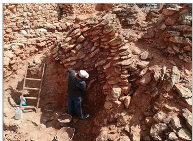
Figura 4.- Labores de llagueado en muro del área meridional.
