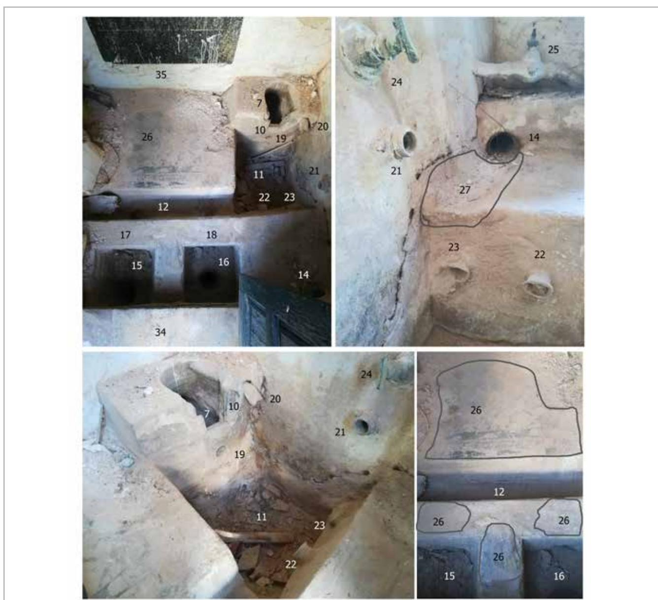
**Figura 5.-** Estado actual del arca de distribución. (7) Cañería nueva, (10) Compuerta, (11) Arqueta de amortiguamiento, (12) Acequia de distribución, (13) Salida de agua, (14) Rebosadero, (15) y (16) Salida de agua con arqueta, (17) y (18) Conexión entre acequia y salida de agua, (19 al 23) Canalizaciones de plomo, (24) y (25) Llaves de paso, (26) Azulejos policromados, (27) Relleno de hormigón, (34) Puerta de acceso y (35) Puerta tapiada.
