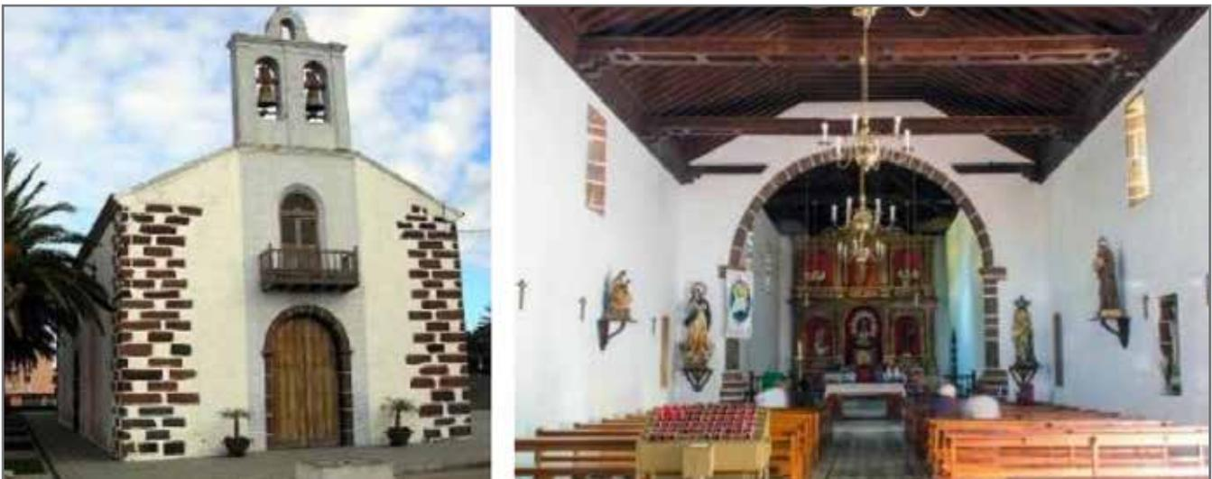
**Figura 6.-** Ejemplo de pequeña iglesia de las Islas Canarias realizada con estructura de fábrica y entramado de madera. Iglesia del Rosario en la localidad de Barlovento, en la isla de La Palma. Planta con 9 m de ancho y 35 m de largo.
