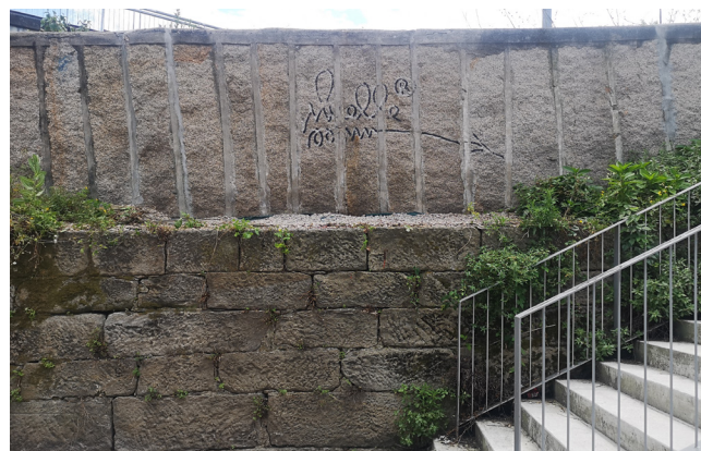
Figura 8.- Imagen final, una vez retirado el andamio
