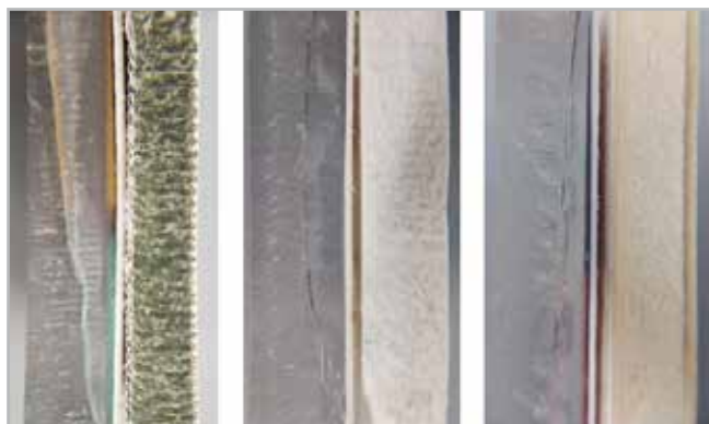
Figura 6.- Delaminación del soporte trasero en obras Face-mounting . Fuente: Elaboración propia.
