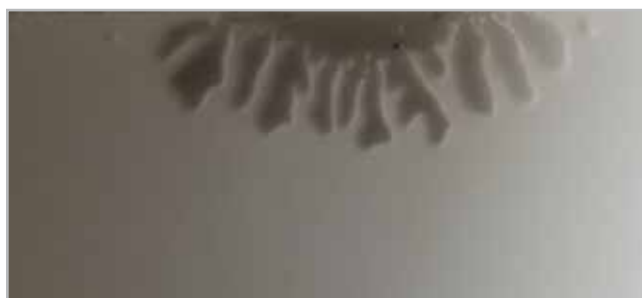
Figura 8.- Expansión de la capa de adhesivo, con la consiguiente delaminación en forma de burbuja con aspecto de copo de nieve. Fuente: Elaboración propia.
