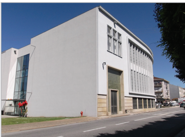
Figura 3.- Fachada del nuevo edificio de oficinas. 1950-1960 (Fotografía: Júlia Faria).
