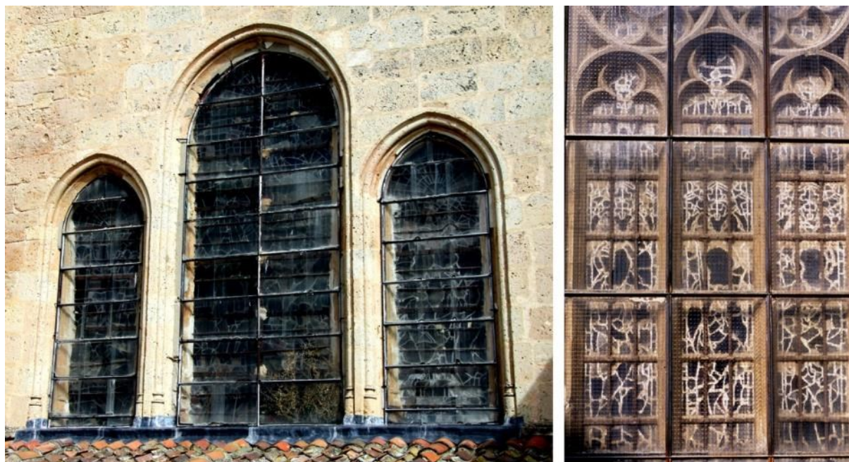
Figura 8. Crecimiento vegetativo y carbonatación de plomos como consecuencias de acristalamientos de protección sin ventilación. Izquierda: catedral de Segovia; derecha: catedral de Girona.
