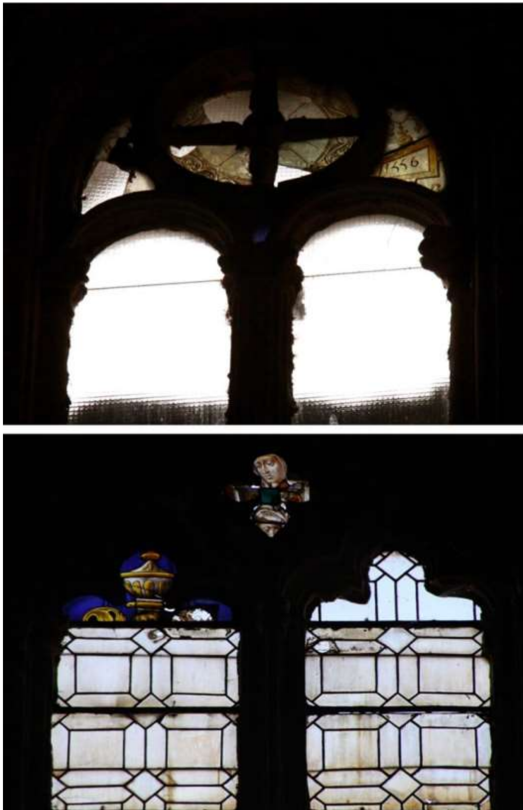
Figura 10. Restos de vidrieras del siglo XVI como consecuencia de un continuado abandono. Superior: iglesia de San Esteban (Salamanca); inferior: iglesia de San Marcos (León).
