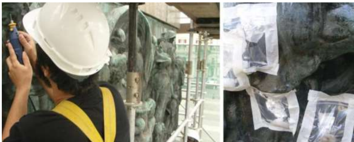
Figura 8. Diferentes tratamientos de las corrosiones: microtorno (izquierda) y método Rosenberg (derecha). ©Jimena Schroeder - Claudia Frigerio.
