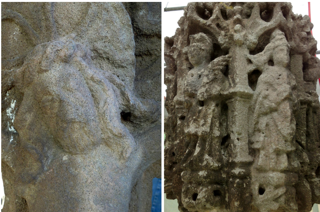
Figura 7. Limpieza con microproyección: detalle de la cruz (izquierda) y del capitel (derecha). © M. Núria Avecilla Palau.
