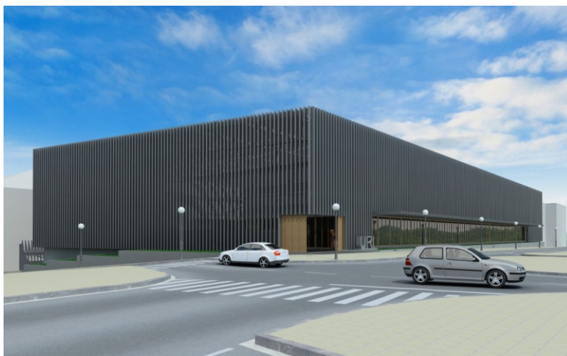
Figura 1: Vista exterior del Centro. Infografía. Astigarraga y Lasarte arquitectos.
