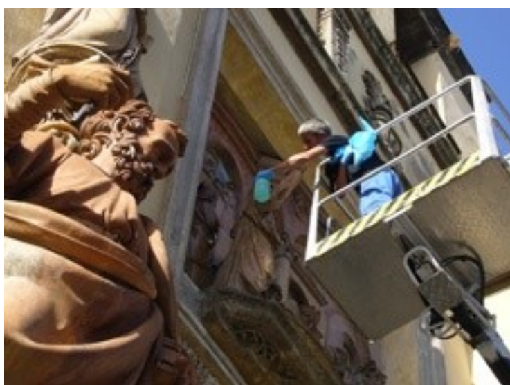
Foto 2- Grúa cesta desde la que se efectúan los trabajos de control y mantenimiento.
