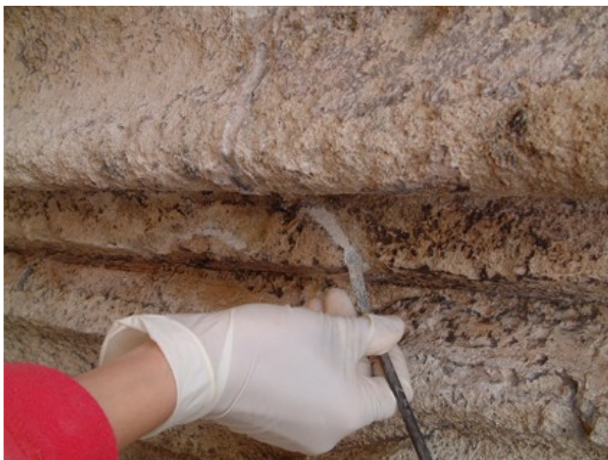
Foto 8.- Sellado de grieta durante los trabajos de mantenimiento en la portada del Nacimiento
