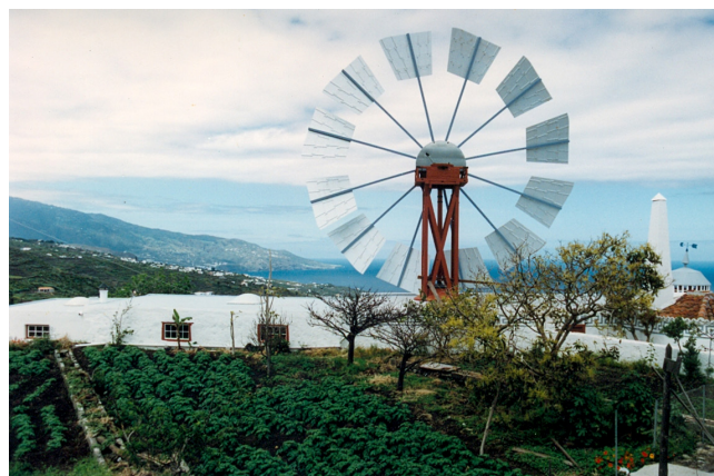
Figura 4.- Molino harinero "Sistema Ortega". TM Villa de Mazo. La Palma. Fotografía: Edvinia Barreto Cabrera
