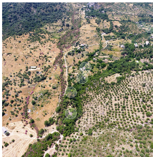
Figura 3.- P.- Tramo de la ribera del Gaidóvar, en Grazales. Presencia de 6 molinos (dcha. a izq.): Molino "de la Cruz", "El Rincón", "El Pero", "El Portal", "El Algarrobo" y "La Pasá de Zahara". Fuente: fotografía con dron de la autora
