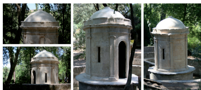
Figura 13.- Vistas gerais após conclusão dos tratamentos de conservação e de restauro.
