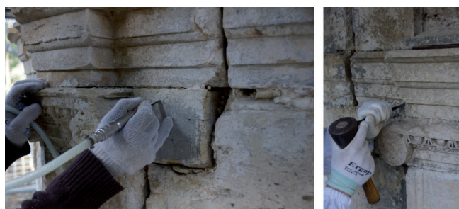
Figura 9.- Remoção de argamassas do tipo cimentícias.
