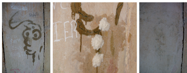
Figura 8.- Limpeza de grafitto por via da aplicação de solventes: à esquerda, antes da limpeza; ao centro, testes de limpeza com bicarbonato de amónio a 15 % do motivo apresentado anteriormente; à direita, aspeto após a remoção das compressas impregnadas com bicarbonato de amónio a 15 % seguida de escovagem e lavagem da superfície.
