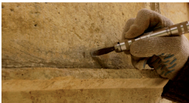
Figura 7. - Limpeza mecânica de vestígios de cimento com microespátula.
