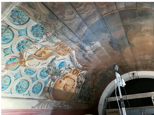
Figura 8. - Observação da pintura durante o processo de limpeza química. ©MF
