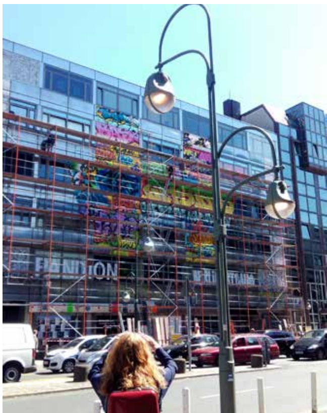
Figura 2. -La fachada, con los andamios ya colocados para su desmantelamiento, exhibe un gran graffiti de colores y la inscripción con el nombre de la inmobiliaria Pandion, Berlín. 1 de junio de 2017. Fotografía propia.
