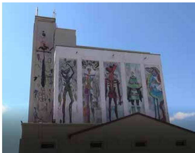
Figura 2.- Silo de Almagro. 2018
