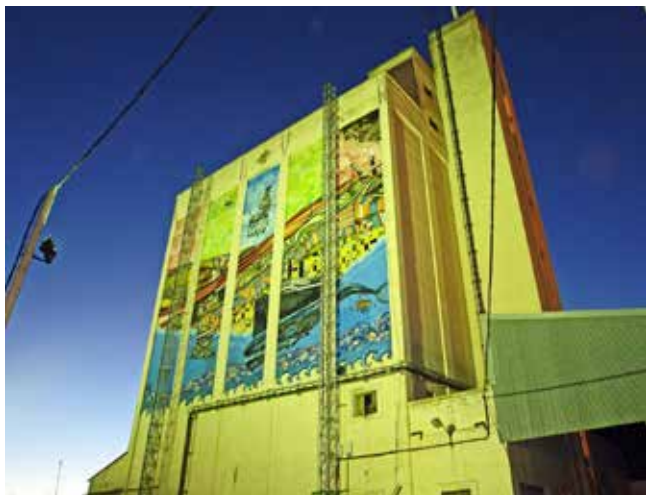
Figura 1.- Silo de Almagro. 2006
