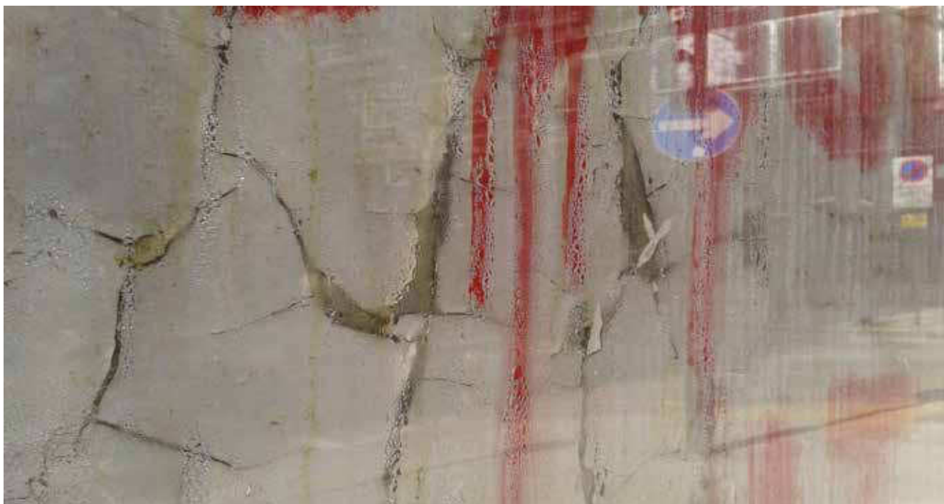
Figura 7. Detalle de las alteraciones sufridas en el mural –falta de transpiración, condensación, suciedad– a causa de la inadecuada colocación de la barrera física.
