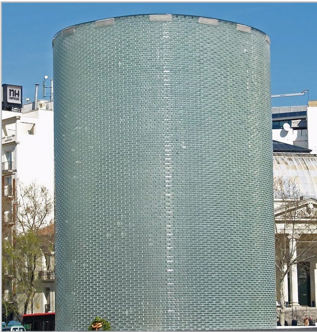
Figura 8.- Estudio de arquitectura FAM. Monumento a las Víctimas del 11M (altura 11 m, diámetro 9,5 m), inaugurado el 11 de marzo de 2007. Inmediaciones de la Glorieta de Carlos V, Madrid.
