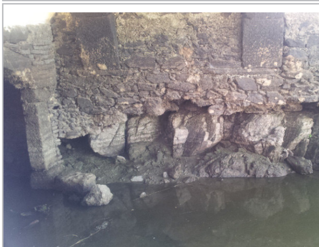
Figura 9.- Estructura de entreplanta y arranque de los arcos de la nave desde la roca. Fuente: Elaboración propia
