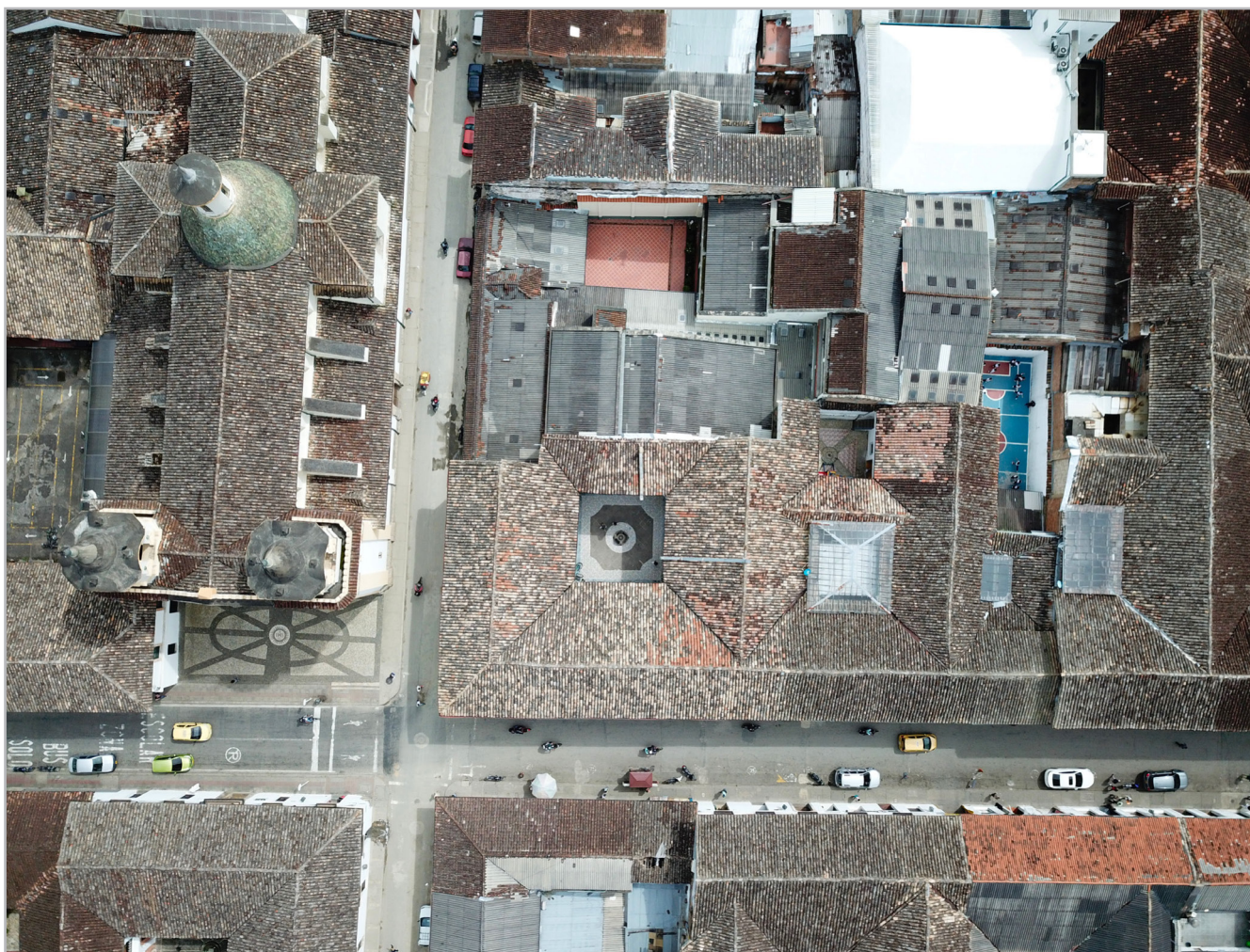
Figura 4.- Ejemplo de la morfología de la manzana contigua a la iglesia de San José en Popayán. Se pueden identificar, en esta vista superior de las cubiertas, cambios en los materiales y técnicas constructivas de las cubiertas de tejas de cerámica.
