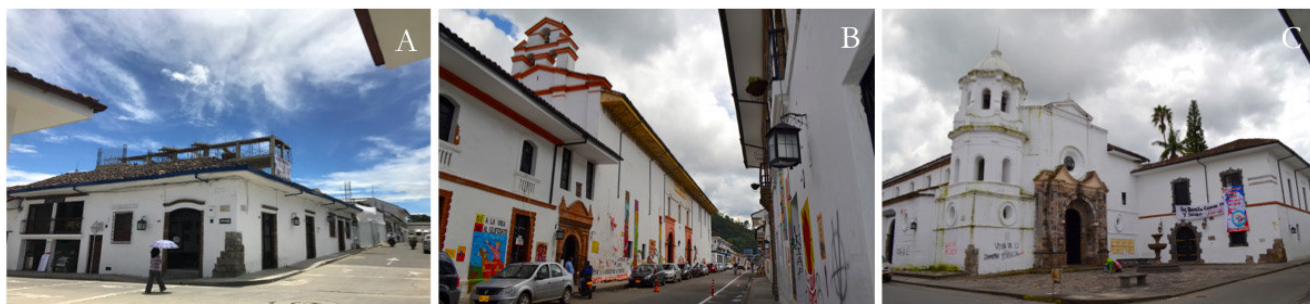
Figura 8. - Ejemplos de alteración en la conservación del patrimonio de Popayán. A) Construcción de edificio modificando los perfiles urbanos ubicado en la Carrera 10 con calle 4 en el sector histórico. B) Grafitis como muestra de actos vandálicos afectando el paisaje urbano en la iglesia de El Carmen. C) Contaminación visual y vandalismo por grafiti en la Iglesia de santo Domingo.
