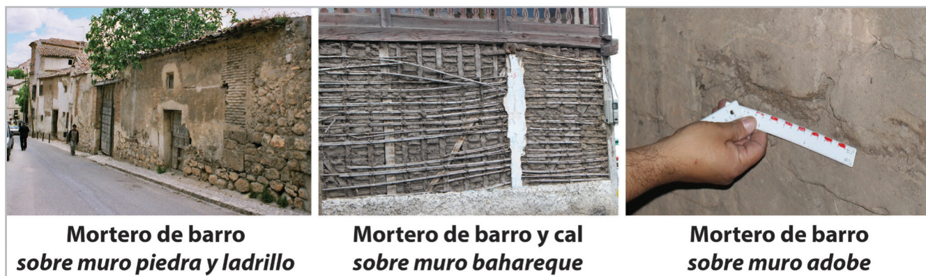
Figura 4. - Revestimientos de barro
