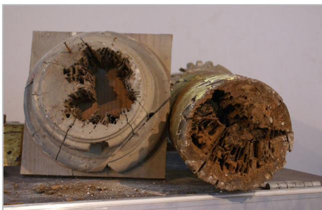
Figura 3.- Incidencia del biodeterioro (termitas).
