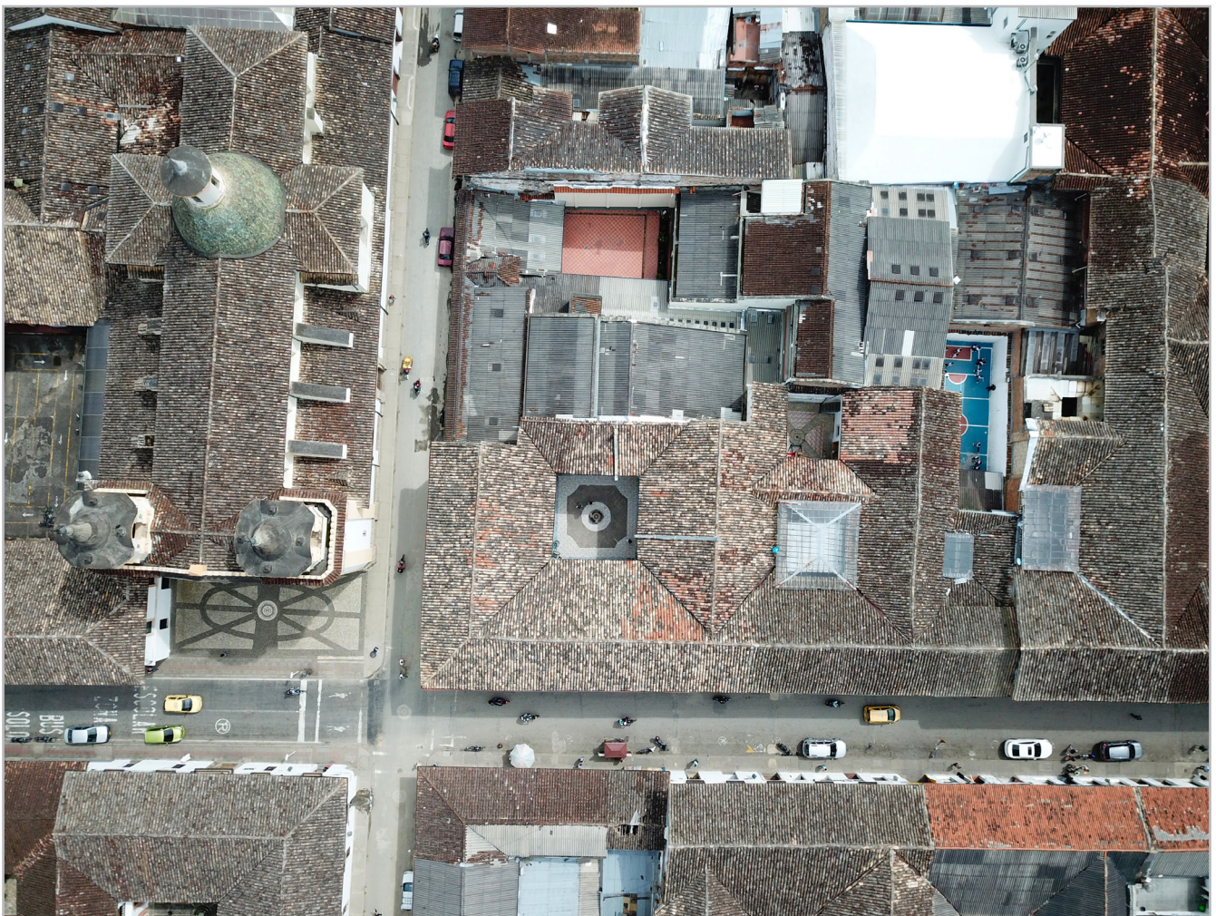
Figura 4.- Ejemplo de la morfología de la manzana contigua a la iglesia de San José en Popayán. Se pueden identificar, en esta vista superior de las cubiertas, cambios en los materiales y técnicas constructivas de las cubiertas de tejas de cerámica.
