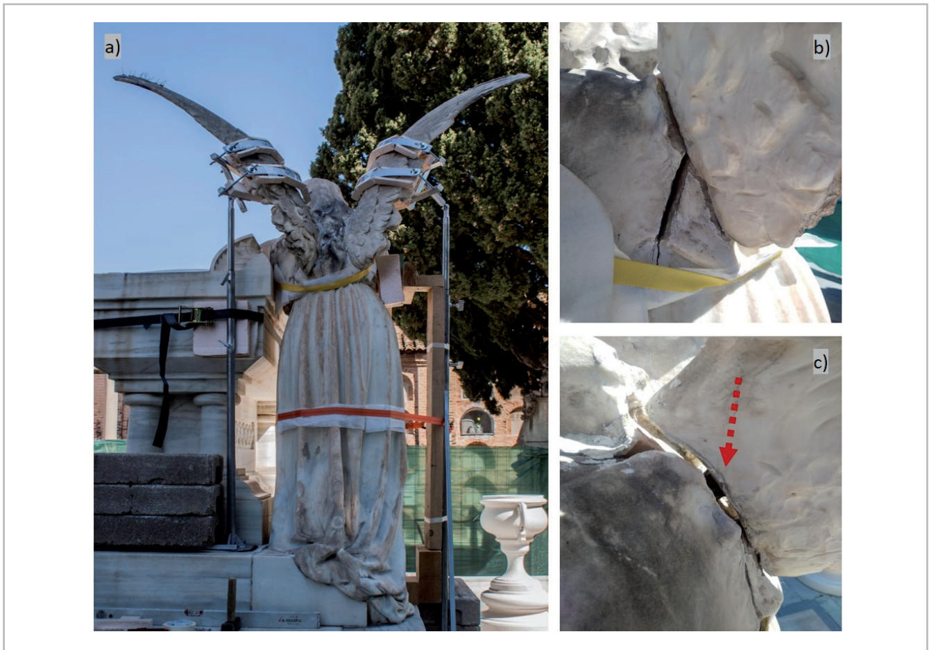
Figura 3 (a-c). - Sistema de arriostrado de las alas de la figura del Ángel durante la fase de desmontaje. a) Vista trasera de la pieza donde se observa el sistema de sujeción telescópico y móvil, instalado de modo independiente, permitiendo la retirada controlada y selectiva de las alas; b) Grietas de considerable grosor tras la retirada del mortero de rejuntado y, c) Espiga metálica empleada, en origen, como elemento de ensamble de las alas a los omóplatos del Ángel.
