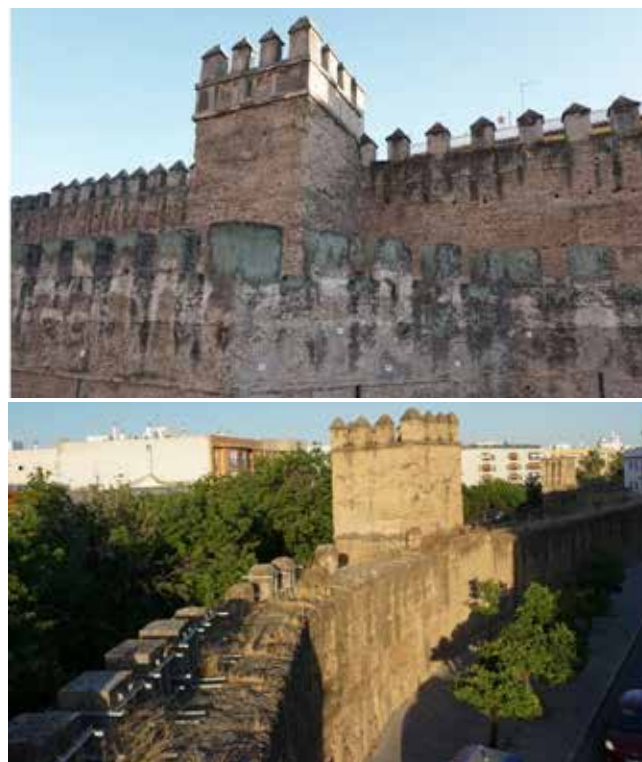
Figura 1.- Vistas de la Muralla de la Macarena desde las zonas interior (izquierda) y exterior (derecha) del recinto fortificado. Elaboración propia.
