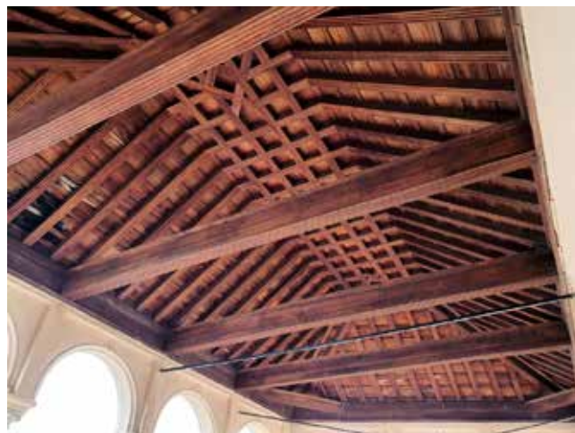
Figura 10.- Techumbre del torreón-mirador. Fotografía propia.
