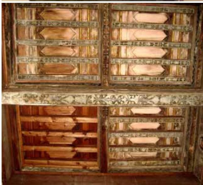
Figura 2.- Techumbre del patio Apeadero y alfarje galería patio principal. Fotografías propias.
