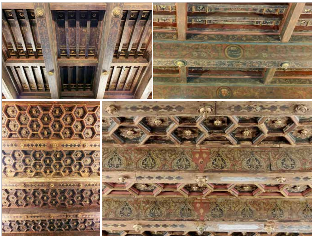
Figura 5.- Techumbres de las salas de la Biblioteca de la Real Academia de Buenas Letras. Fotografías propias.
