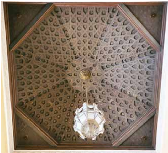
Figura 6.- Artesonado en escalera. Fotografía propia.
