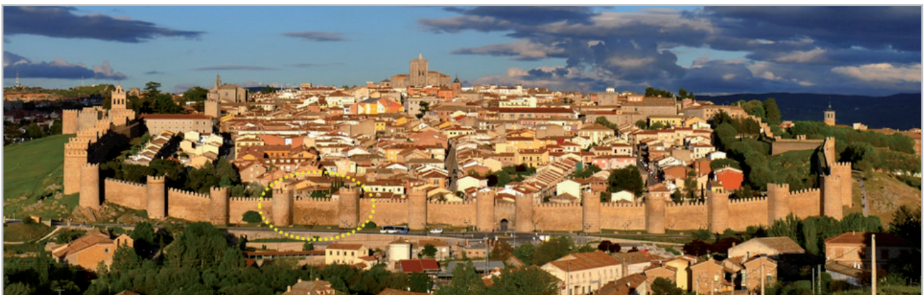
Figura 1. - Vista oeste de la ciudad medieval de Ávila, 2020-05-11. El círculo indica la situación del tramo 44-45 de la muralla.
