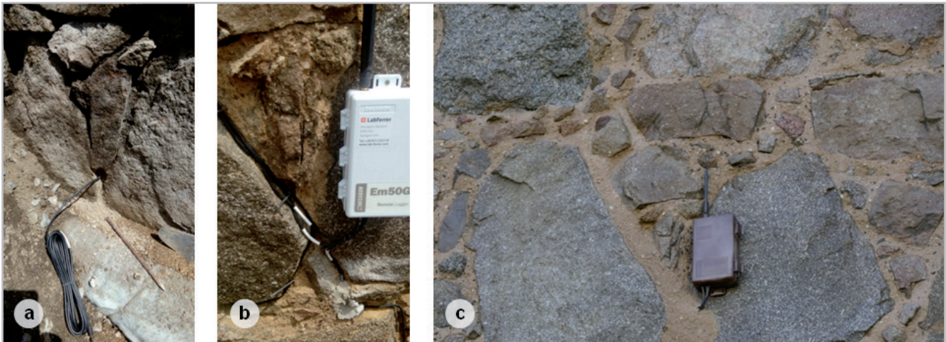
Figura 5.- Colocación de las sondas HS1, HS8 y el registrador LE, 2017-06-01.
