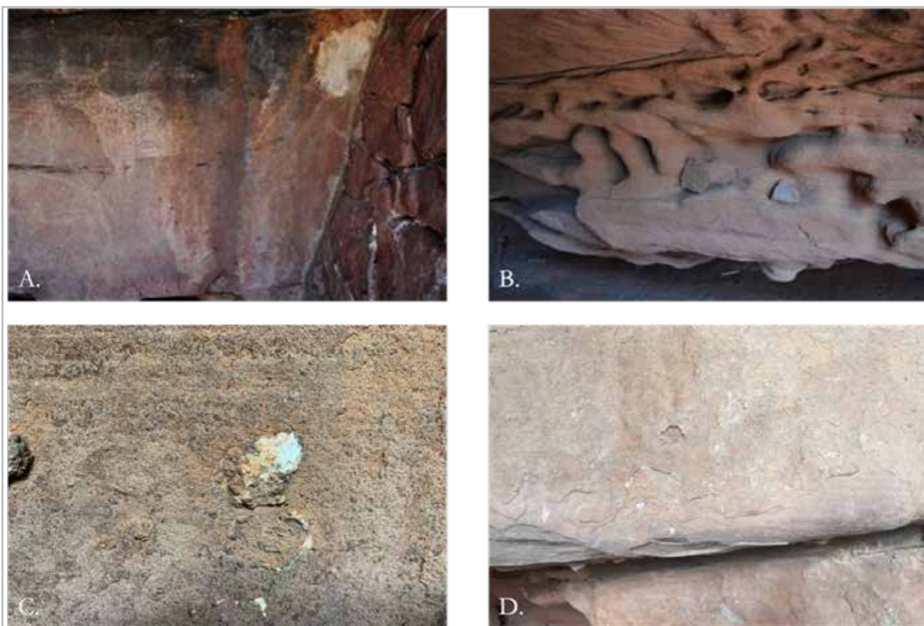
Figura 3.- Fenómenos de alteración en el abrigo de los Toros del Prado del Navazo . A). Lixiviación; B). Tafoni o erosión alveolar; C). Concreciones insolubles y sustancias detríticas; D). Agrietamientos.
